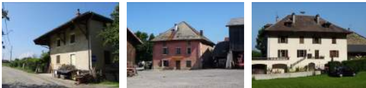
Photo 19 : Exemples de façades des parties habitations
