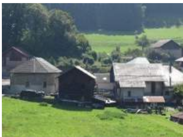
Photo 18 : Exemples de toitures dans le bâti ancien
