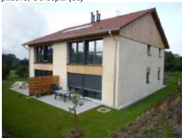
Régis Colin architecte, Quatre logements passifs, Gerbépal (88)
