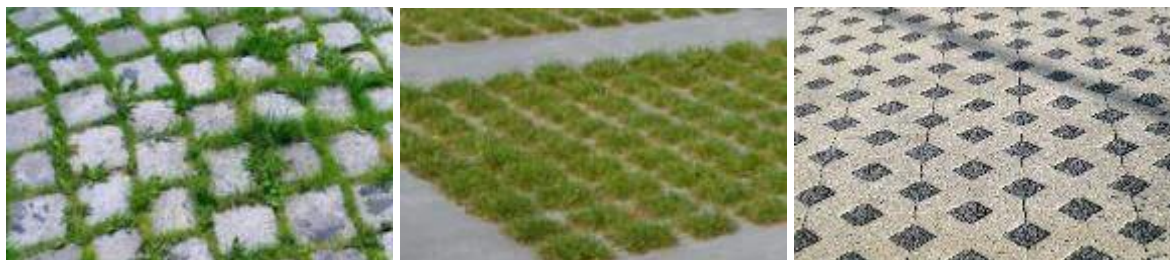
Ex. de traitement de sol limitant l'imperméabilisation
